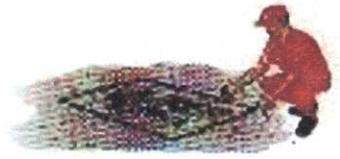
2- Recortar o revestimento a ser removido, com a utilização de equipamentos mecânicos tipo martetele pneumático e/ou serra clipper, preferencialmente. A utilização de chibancas e picaretas deve ser evitada devido a baixa produtividade e a dificuldade de se romper espessuras consideráveis sem trincar ou abalar o pavimento que não necessite ser removido. É fundamental que a face do recorte faça um ângulo de 90° com o revestimento existente.
