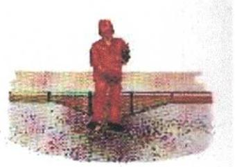
2- Executar a pintura de ligação na área afetada, utilizando emulsão asfáltica tipo RR -1C, pura, ou diluída no máximo com 20% (vinte por cento) de água a critério da fiscalização. A emulsão deve cobrir toda a área que vai receber a massa asfáltica, sem se acumular em poças. Deve-se estender a pintura de ligação por 10 a 20 cm além da área afetada, isto é, para cada lado do abatimento.
