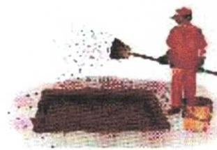
6- Preencher o local com CBUQ Faixa C, na temperatura entre 110°C e 177°C, ou PMF de graduação densa na temperatura ambiente, no mínimo três camadas. O preenchimento deverá ser iniciado 5 (cinco) minutos após a execução da pintura de ligação devido à necessidade de ruptura da emulsão asfáltica. Colocar a 1ª camada, máximo de 5 cm de espessura, nivelamento abaixo do pavimento existente.
