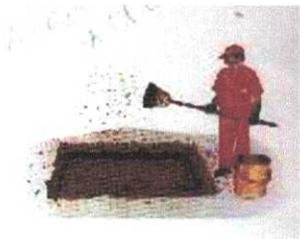
7- Preencher o local com CBUQ Faixa C, na temperatura entre 110°C e 177°C, ou PMF de graduação densa na temperatura ambiente. O preenchimento deve ser cuidadoso e ser iniciado 5 (cinco) minutos após a execução da pintura de ligação, devido à necessidade de ruptura da emulsão asfáltica. Com a utilização de rastelo a massa deve ser bem espalhada, preenchendo todo o espaço formado pelo recorte, nivelando a massa com o pavimento existente.
