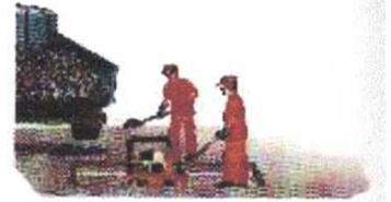
8- Executar a pintura de ligação no fundo e nas paredes verticais da área recortada, utilizando emulsão asfáltica tipo RR-1C, pura, ou diluída no máximo com 20% (vinte por cento) de água, a critério da fiscalização. A emulsão deve cobrir toda a área que vai receber a massa asfáltica, sem se acumular em poças. Deve-se estender a pintura de ligação por 10 a 20 cm sobre o pavimento existente, isto é, para cada lado do buraco.
