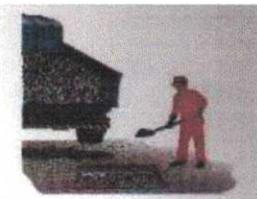
6- Executar a pintura de ligação sobre o material utilizado em III.2.-5. e nas paredes verticais da área recortada, utilizando emulsão asfáltica tipo RR -1C, pura, ou diluída no máximo com 20% (vinte por cento) de água, a critério da fiscalização. A emulsão deve cobrir toda a área que vai receber a massa asfáltica, sem se acumular em poças. Deve-se estender a pintura de ligação por 10 a 20 cm sobre o pavimento existente, isto é, para cada lado do buraco.
