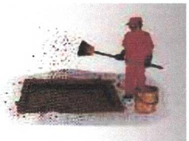
6- Preencher o local com CBUQ Faixa C, na temperatura entre 110°C e 177°C, ou PMF de graduação densa na temperatura ambiente. O preenchimento deve ser cuidadoso e ser iniciado 5 (cinco) minutos após a execução da pintura de ligação, devido à necessidade de ruptura da emulsão asfáltica. Com a utilização de rasteiro
