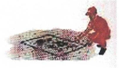
2- Recortar o revestimento a ser removido com a utilização de chibancas e picaretas.
