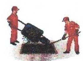
Em seguida, executa-se uma primeira compactação (4 passadas com compactador tipo placa vibratória) aplicando em seguida uma nova camada de massa. A aplicação desta nova camada deverá atingir toda a área pintada (10 a 20 cm externos ao recorte).
