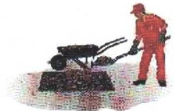
4- Efetuar a limpeza da área utilizando vassouras ou compressor. Na varrição ou limpeza com o compressor, retirar todo o pó que estiver solto. Com um regador, espalhar pouca água, suficiente para assentar a poeira e garantir a inexistência de pó solto, se necessário. A varrição ou limpeza com o compressor deverá se estender sobre o pavimento existente, numa área maior que a prevista para a pintura de ligação.
