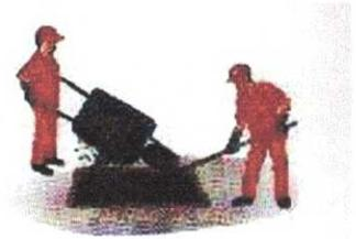
8- Espalhar pouca água sobre toda a camada final da massa, utilizando-se de um regador. Não pode ocorrer formação de poças. O objetivo é facilitar o deslizamento do compactador sobre a massa e proporcionar um acabamento liso quando da operação de compactação final.
