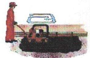
No caso de trechos de comprimento superior a 20 metros e 3 metros de largura, é recomendável a utilização de compactador de maior potência, tipo CC800, ou equivalente.
