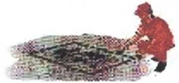
2- Recortar o revestimento a ser removido conforme a área escolhida, com o auxílio de equipamento mecânico, martetele pneumático ou serra clipper preferencialmente. A utilização de chibancas e picaretas só é recomendável quando o pavimento tiver espessura inferior a 5 cm.
